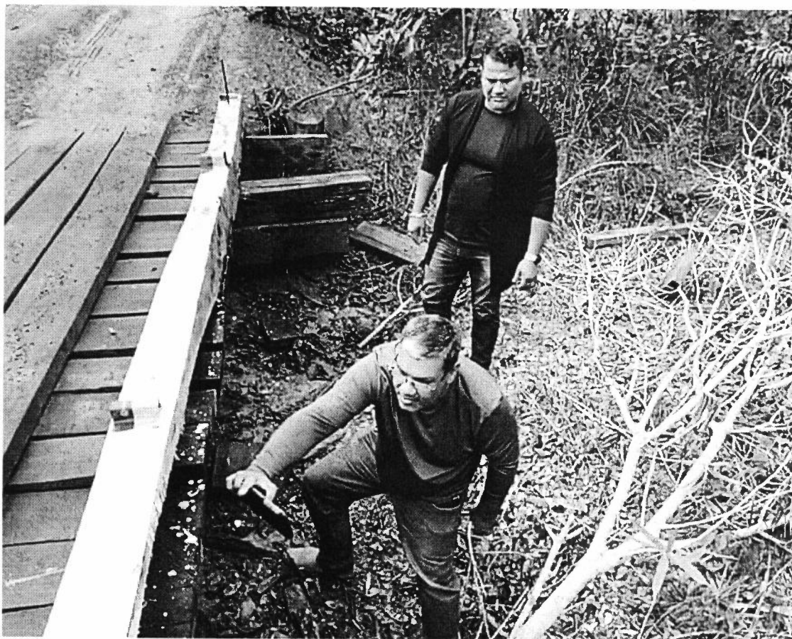
Vereador Maurício Helpis fiscaliza reforma da ponte do córrego Guasca
